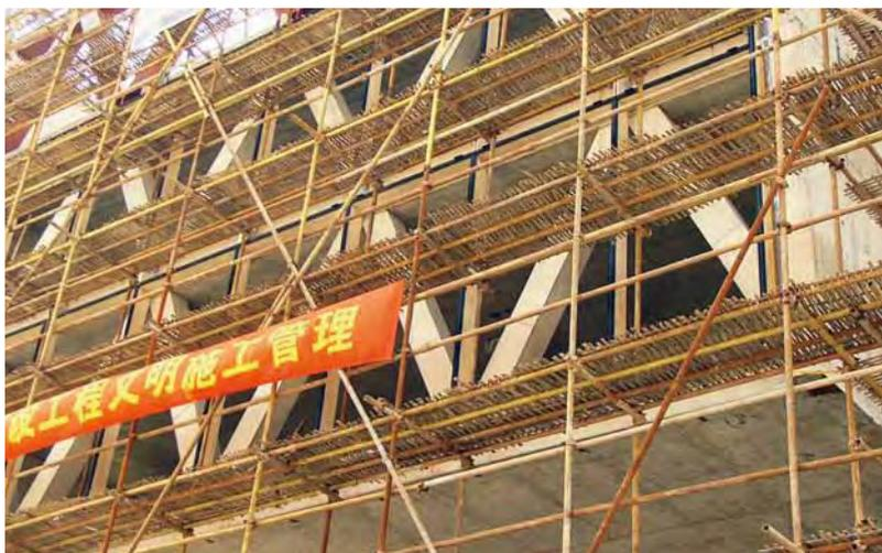
◀ Die Fassadenpfosten sind genau auf die diagonalen Stahlbetonstützen ausgerichtet. Die Montage erfolgte auf ortsüblichen Bambusgerüsten
