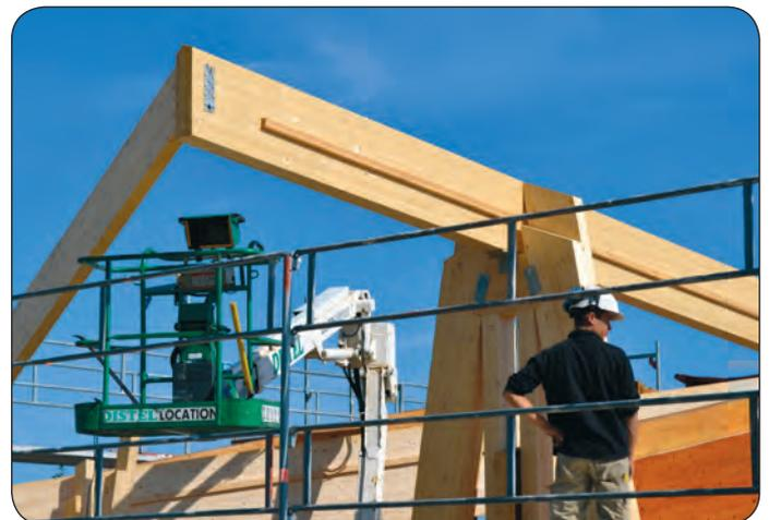
▮ Schräge Anschlüsse wurden teils mit RICON® S als hochbelastete Haupt-Nebenträger-Anschlüsse bis 50 kN realisiert.
