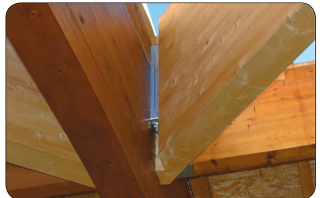
■ Für die Verbinder wurden bereits im Zimmereibetrieb mit der Abbundmaschine Vertiefungen gefräst, sodass auf der Baustelle unsichtbar montiert werden konnte.
