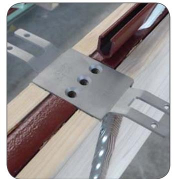
■ Verstärkungsplatte, für zusätzliche Lastaufnahmen bis zu 320 kg.
