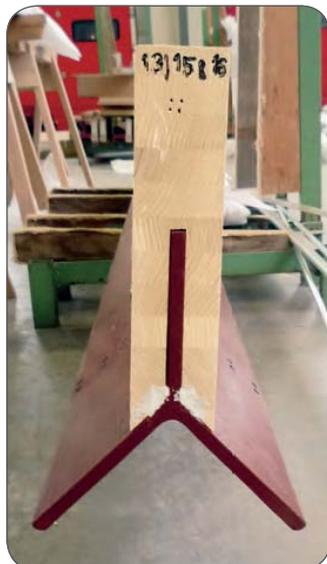
Y-förmige Stahlstege verstärken wegen der hohen Windlasten die Eckpfosten der Holz-Glas-Fassade.
