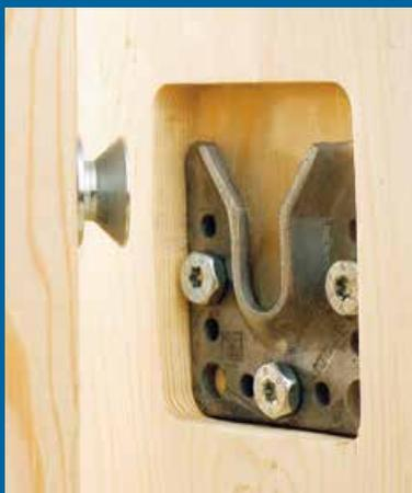
▲ So funktioniert das System: Vormontieren, einhängen, fertig
