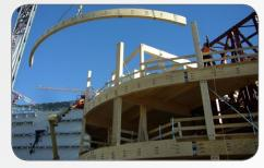
Der Pavillon mit seinen drei Stockwerken und einem 1500 m² großen Gewölbe, größtenteils aus Holz, verfügt über 730 individuelle Trägerteile. Er ist in seinem Inneren bis zu 8 Meter und teils bis zu 12 Meter hoch.
