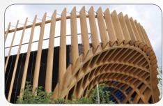
Ein Gitter aus gekrümmten BSH-Trägern mit einem Abstand von je 1,5 Meter bildet die formvollendete Decke der "Markthalle". Der planerische Wunsch waren Verbinder aus Stahl, die sowohl einen kurzem Einhängeweg wie auch die Wiederzerlegbarkeit des Gebäudes ermöglichen.
