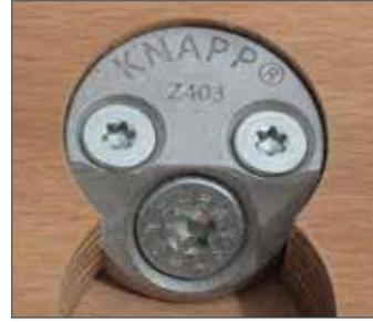
3 Schrägverschraubung mit einer SK-Schraube  $\varnothing$  8-12mm schließen.
