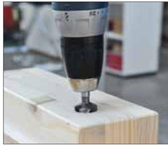
2 T-Joint 20 Bohrung mit ca. 2mm Fase ansenken.
