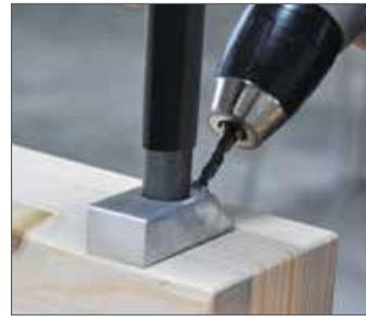
3 Schrägverschraubung mit Knapp-Bohrschablone vorbohren.
