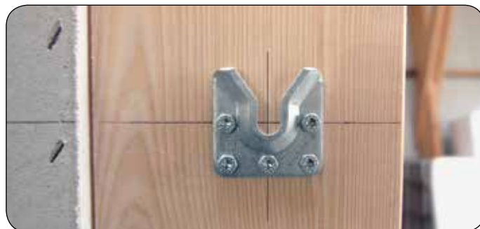
Gegenstück mit verschraubter WALCO® V Verbinderrplatte.
