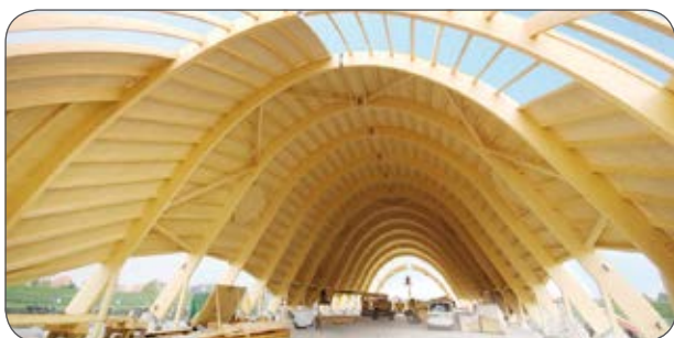
↑ Durch die unterschiedlich hohen Bögen müssen alle Pfettenstirnseiten „windschief“ zugeschnitten sein. Der Pfettenabstand ist mit 1 m relativ gering gewählt.
