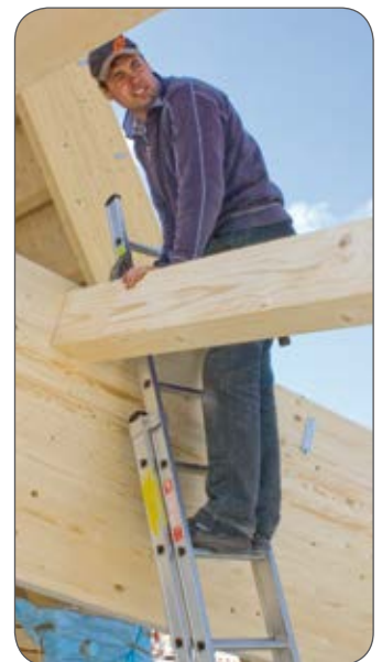
Einfaches Einfädeln der Pfetten ohne Verkanten.
