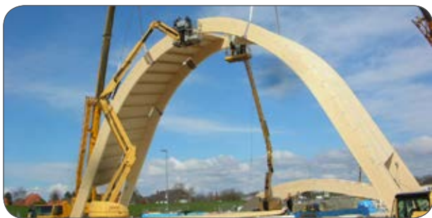
↑ Aufrichten der ersten beiden vorgefertigten Bogenelemente.
