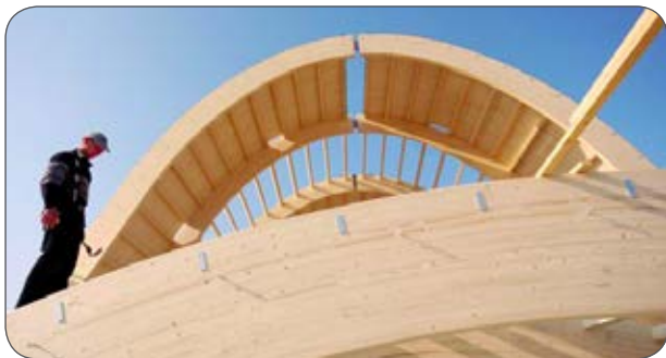
↑ Die Bogenbinder aus BS14 (GL28C) sind durchgängig 18 cm breit, variieren aber in der Höhe zwischen 48 cm und 95 cm.
