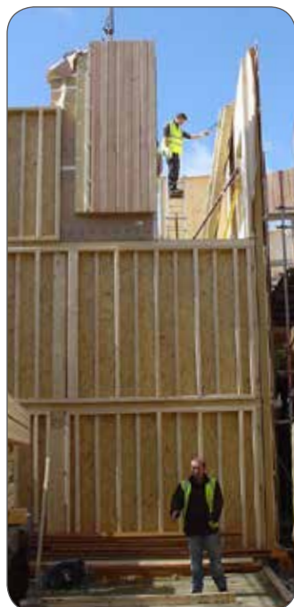
Die Montage musste auf engstem Raum erfolgen.
