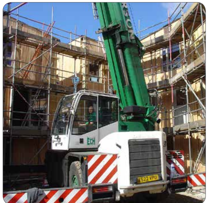
Die Wände wurden nach ihrer Ankunft aus Deutschland in ihre Position gehoben und sofort montiert.
