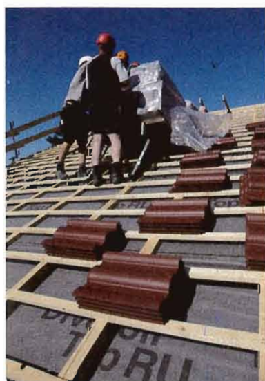
► Die Handwerker verteilen die Dach-Steine in verlegegerechten Einheiten auf dem Dach
