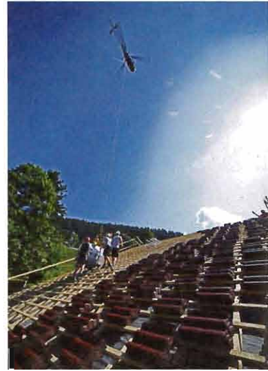
▶ Die Dach-Steine wurden verlegegerecht auf dem Dach abgelegt
