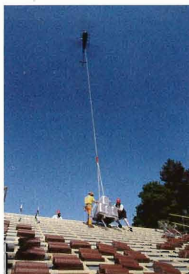
► Der Landehelfer ist per Funk mit dem Piloten verbunden und packt ordentlich mit an
