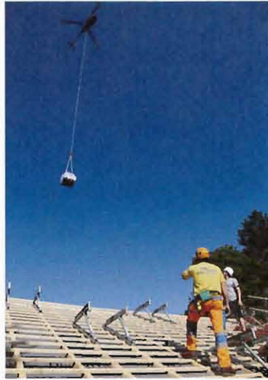
◀ Phasen des Anflugs der Dach-Steine
