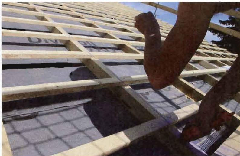
◀ Vor dem Dachdecken wird das Dach abgeschnürt
